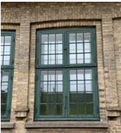
Fig.32. Bygningsdetaljer som døre og vinduer spiller en særlig rolle for helhedsindtrykket på Sankt Hans. Det skyldes dørenes fine profileringer og vinduernes elegante, lette udtryk. Det er vigtigt at bevare områdetets korspostvinduer med tynde stålsprosser. Ny termovinduer vil give et helt andet udtryk, fordi karme, rammer og sprosser skal være meget kraftigere. Her ses et eksempel på en dør og et vindue på bygning 21 af Kurhus. Kalfatring omkring vinduer bør foretages med hydraulisk mørtel uden cement. De steder, hvor der oprindeligt har været dækningsliste, bør kalfatringen afdækkes med liste malet vogngrøn.
