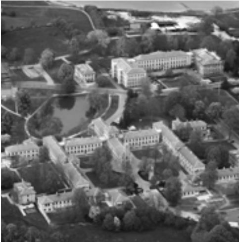
Fig.4. Sankt Hans Vest hospitalsanlæg er bygget over en periode på over 200 år af forskellige arkitekter. Kurhus (i forgrunden) er fra 1852-1854 efter tegninger af Bindsbøll.
