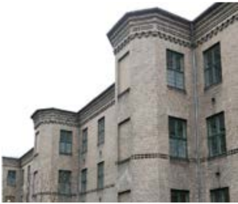
Fig.30. Gennemgående materialer og ornamentering knytter de fleste bevaringsværdige bygninger sammen arkitektonisk. Derfor fastsætter lokalplanens generelle bestemmelser, at facader og gavle skal bevares i blank mur af gule teglsten - altså med synlige teglsten uden overfladebehandling som f.eks. puds og maling. Tage og sålbænke skal fastholdes i naturskifer. Tagrender og nedløbsrør skal være udført i zink.
