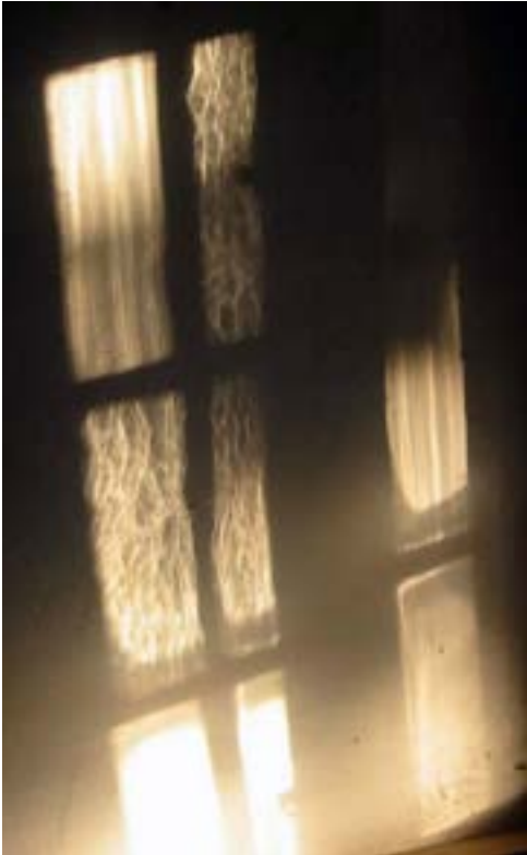
Fig.33. Ved udskiftning af ruder er typen af rudeglas værd at overveje. Glastypeen har betydning indefra, fordi typerne bryder lyset på hver sin måde. Vinduesglasset har også betydning for oplevelsen udefra, fordi glastyperne reflekterer omgivelserne forskelligt. Derfor giver det mening at bruge traditionelle typer vinduesglas. Nederst til venstre ses moderne float-glas uden struktur. De øvrige ruder er af cylinderglas (spættet struktur) og trukket glas (stribet struktur).
