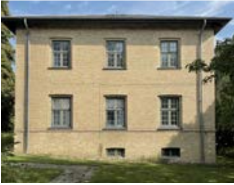
Fig.47. Facade mod vest på Vesterhus.
