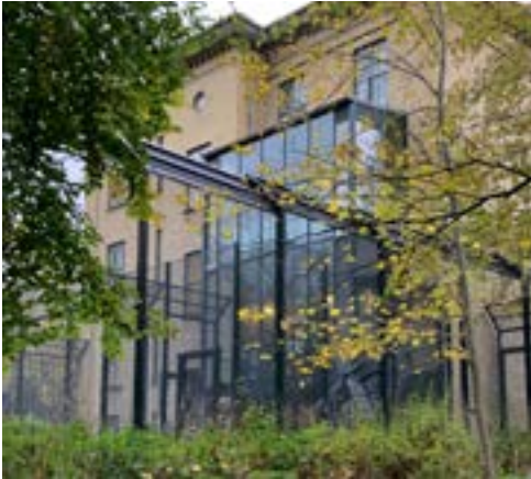
Fig.39. Glastilbygningen og indhegningen på Sønderhus' sydfacade må rives ned og erstattes med vinduer som oprindeligt eller med franske altaner.
