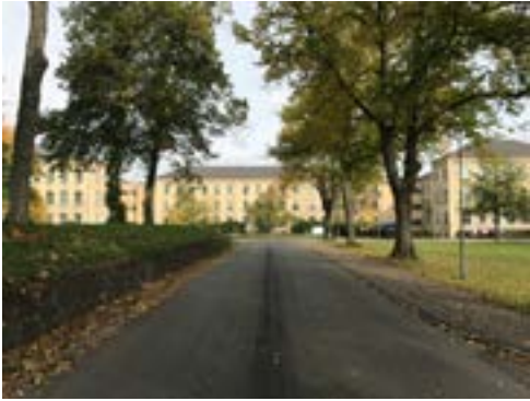
Fig.62. Langs Søndre Allé er der en støttemur i kampesten som optager terrænet mellem parken og vejen.
