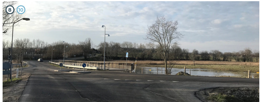
Ny cykel- og gangbro er blevet etableret på Boserupve, der krydser det netop indviede, naturgenopretningsprojekt Langvad Å.
