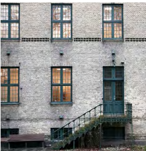
Fig.6. Vestfacaden på Østerhus med den karakteristiske gule teglfacade med vogngrønne døre, vinduer, friskluftsventiler og trappens rækværk.
