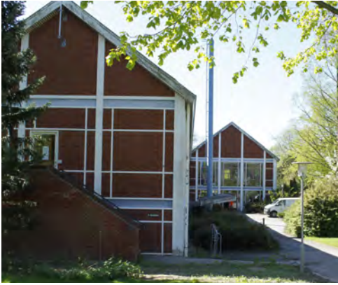
Fig.4. Her ses billeder af den eksisterende bygning, Centralkøkkenet, som har fungeret som køkken for hele Sankt Hans samt kantine for medarbejdere. © Roskilde Kommune
