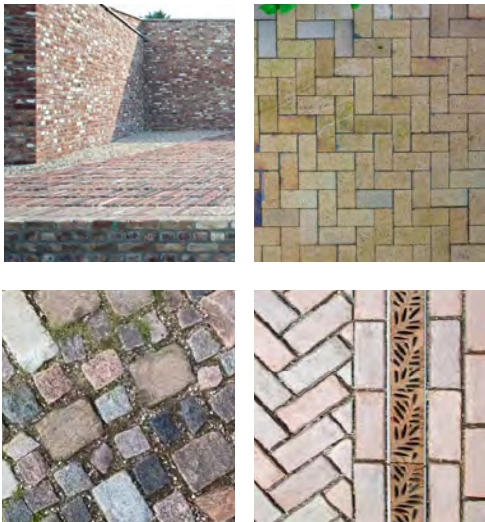
Fig.38. Eksempler på belægning i tegl og granit. © Ø.v. th. Roskilde Kommune © Ø.v. tv. Ed Gumuchian
