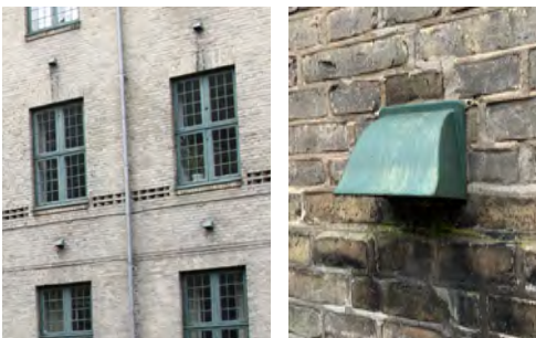
Fig.34. Foto af Østerhus hvor ventilation er udformet som ornament i facaden.
