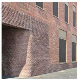
Fig.27. Eksempel på indkørsel til parkeringskælder, hvor facademateriale er trukket med ind i åbningen.
