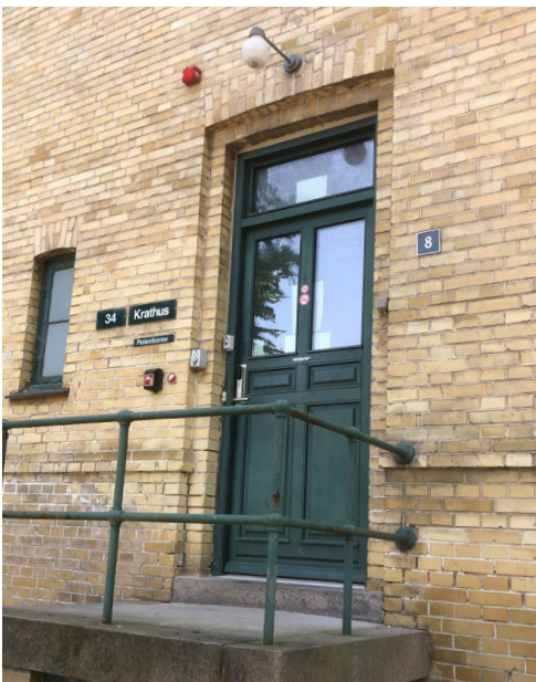
Fig.12. Bebyggelserne har mange smukke bygningsdetaljer. Her ses indgangspartiet ved Krathus. © SDFE, Roskilde Kommune
