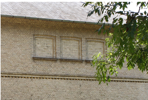
Fig.18. Eksisterende vindueshuller i den vestlige facade af Bygning 32 © SDFE, Roskilde Kommune
