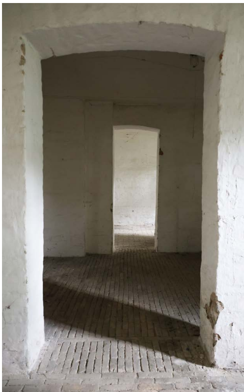
Fig.21. Eksisterende buer under terrasse i bygning 32 mod vest. © ERIK arkitekter
