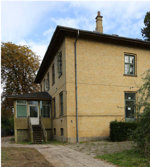
Fig.22. Eksisterende udestue på vestfacaden af krathus, som skal nedrives. © ERIK arkitekter
