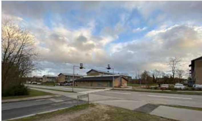
↑ Krydset Bjergmarken/Låddenhøj, hvor der etableres signalregulering og svingbaner for at sikre en bedre trafikafvikling gennem krydset
