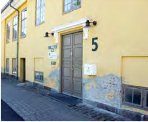
Fig.24. Slottets hovedindgang med fin detalje med overliggende bæret på volutkonsoller. © Erik Arkitekter
