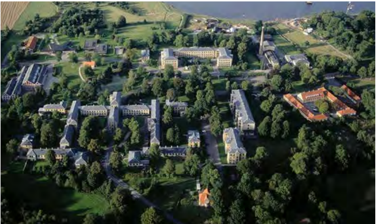
Fig.11. Slottet er en vigtig del af kulturmiljøet på Sankt Hans og er den allerførste oprindelige bygning som blev brugt til psykiatrisk hospital, og er derfor vigtig i forståelsen af Sankt Hans historie. © SDFE, Roskilde Kommune
