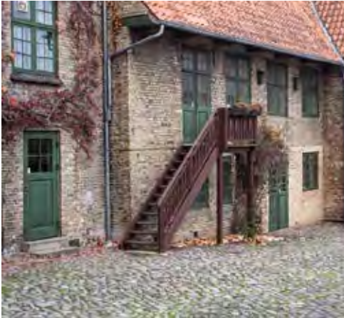
Fig.25. Eksempel på trappe i træ med fint detaljeret gelænder på bevarelsesværdig bygning, Marcussens gård i Aabenraa. © Realdania
