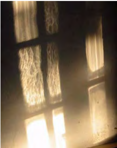
Fig.34. Ved udskiftning af ruder er typen af rudeglas værd at overveje. Glastypen har betydning indefra, fordi typerne bryder lyset på hver sin måde. Vinduesglasset har også betydning udefra, fordi glastyperne reflekterer omgivelserne forskelligt. Derfor giver det mening at bruge traditionelle typer vinduesglas. Nederst til venstre ses moderne floatglas uden struktur. De øvrige ruder er af cylinderglas (spættet struktur) og trukket glas (stribet struktur). © Center for Bygningsbevaring og Søren Vadstrup.
