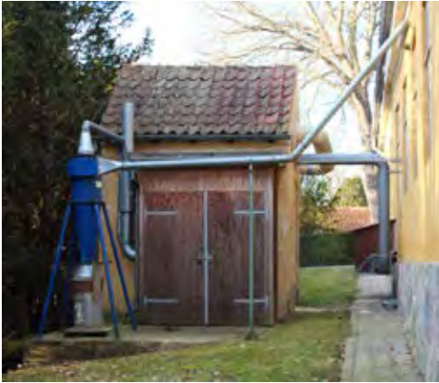
Fig.32. Den eksisterende sekundære bygning bag ved vestlængen har været brugt til udsugning for træværkstedet © Roskilde Kommune
